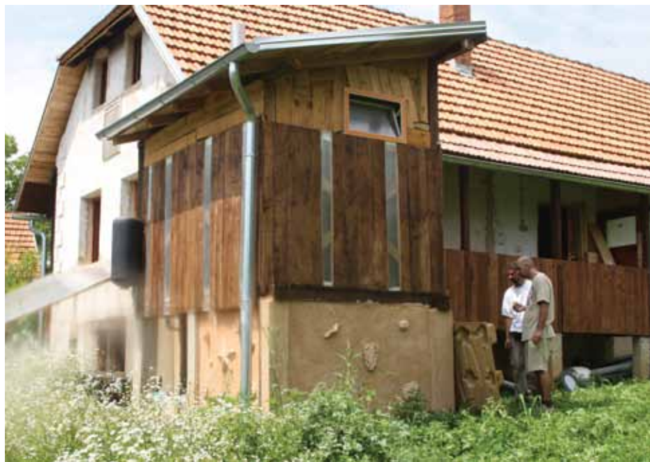
Slika: Kompostni WC izgrađen kao samostojeći objekt. Drveni dio kućice čini zidove WC-a, a donji, betonski dio je kompostna komora sa dva odjeljka. Ekoselo Blatuša.
