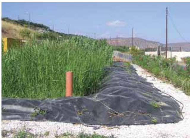
Slika: Primjer velikog biljnog pročištača sa potpuno razvijenom vegetacijom, dakle radi punim kapacitetom.
