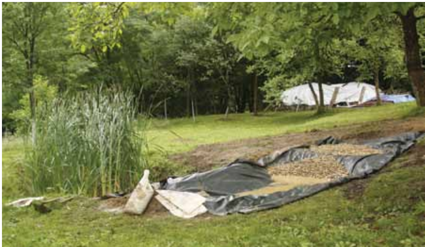
Slika: Biljni pročistač u izgradnji. Budući da je građen na kosom terenu, izveden je u tri nivoa. Ekoselo Blatuša
