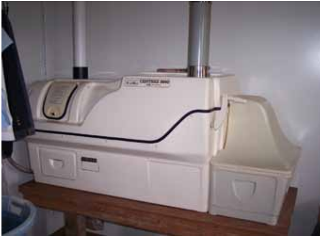
Slika: Kupovni kompostni WC koji se ugrađuje u prostoriju ispod kupao-nice, najčešće podrum.
