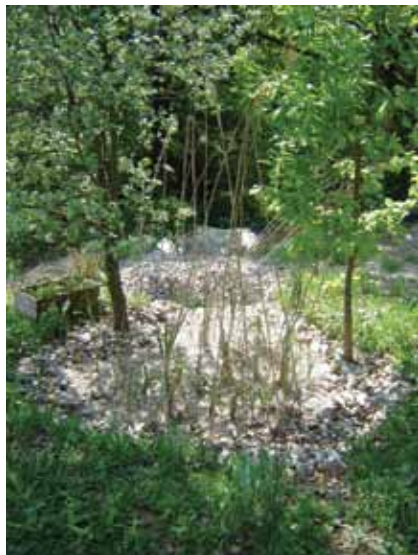
Slika: Završeni pročištač sa tek posađenim biljkama.
