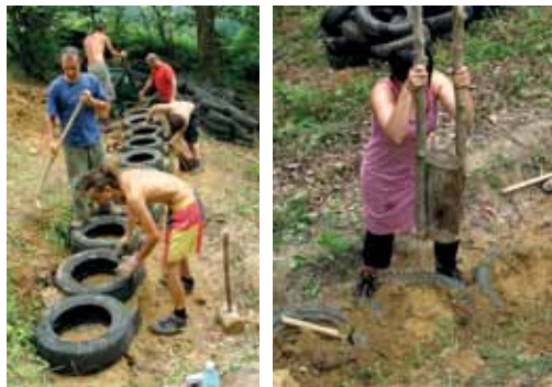
Slika: Gradnja temelja od automobilskih guma. Posao je fizički zahtjevan, ali nije potrebno nikakvo tehničko predznanje za ovaj tip gradnje.
